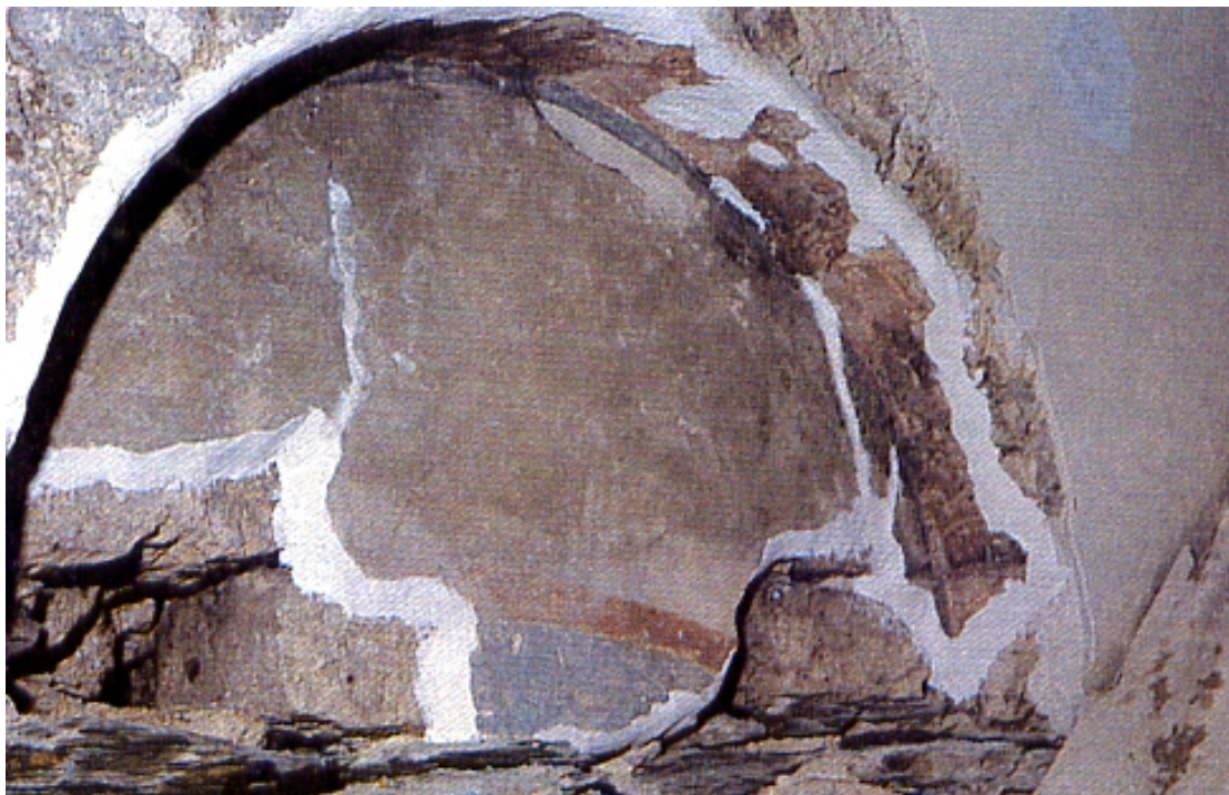
Abb. 254: Saalbau auf der Marksburg (erste Hälfte 13. Jahrhundert). Reste einer dekorativen Farbfassung an einem heute vermauerten Arkadenfenster an der ursprünglichen Hoffassade (heute im Gebäudeinneren). (aus: Hartmann 1993, Abb. auf S. 106)
